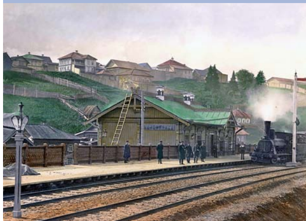
Станция Мотовилиха, нач. XX в.
