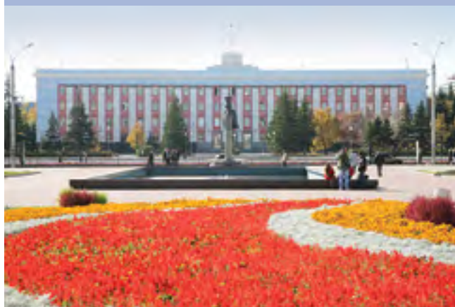
Здание администрации Алтайского края
